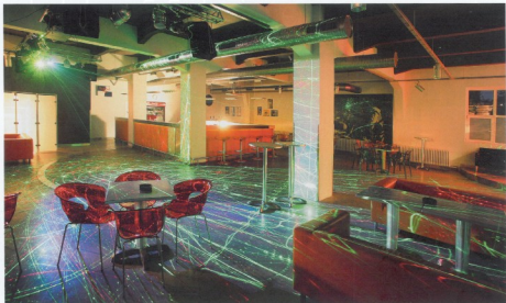
■ Interiérové osvetlenie je rozvedané po hĺbkových roštach s bodovým osvetlením.
